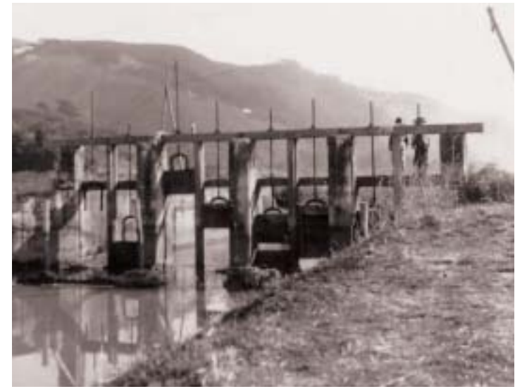
四日市場坂本地区にあった八枚水門
