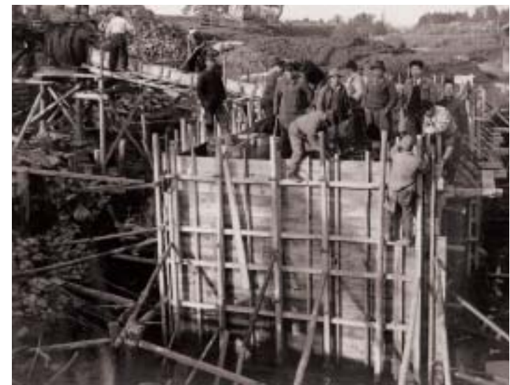
最初の四日市場排水機場の建設工事(昭和25年頃)
