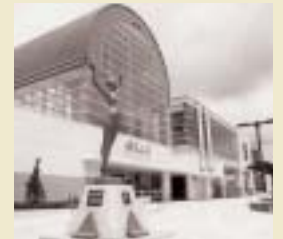
平成10年6月、槻木駅舎とコミュニティプラザの合築工事が完成
