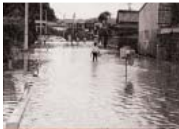
昭和61年8月、集中豪雨により、被害総額207,000万円に及んだ
