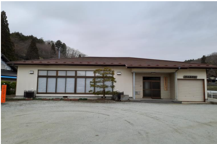
葉坂構造改善センター
