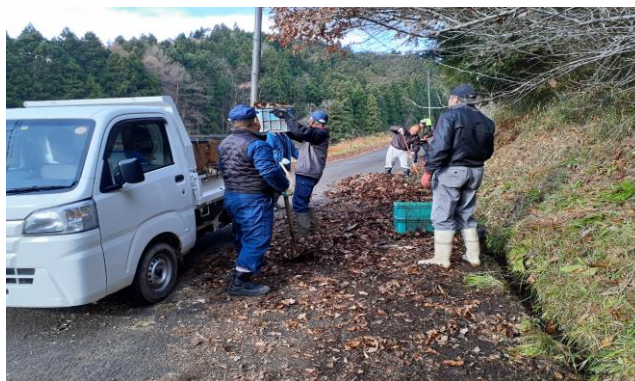
側溝整備作業
