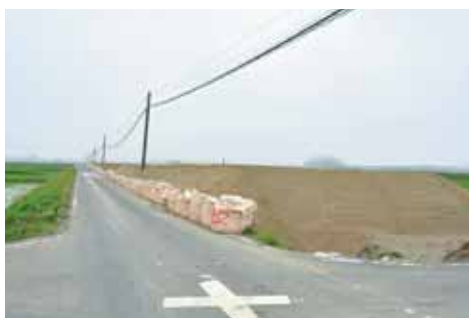
さいか 載荷盛土工事状況
