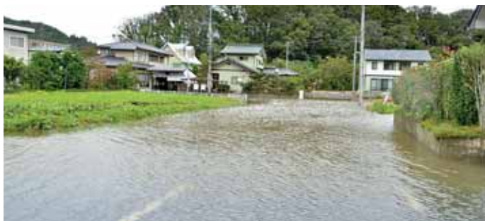
急務である冠水対策
