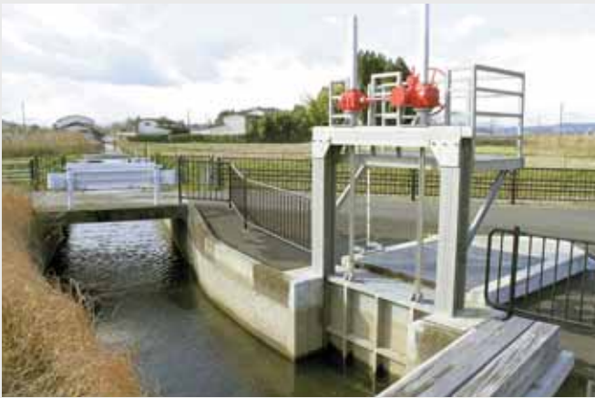
槻木、四日市場地区の洪水対策のため、雨水を稲荷山用水路から四日市場排水機への導水路に排水するための「四日市場分水門」
