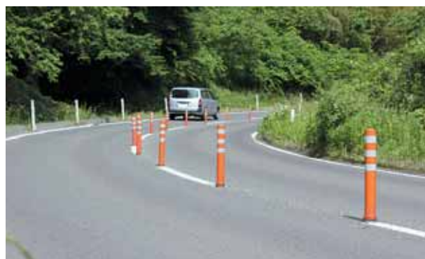
ポールコーンを設置し注意を促す
