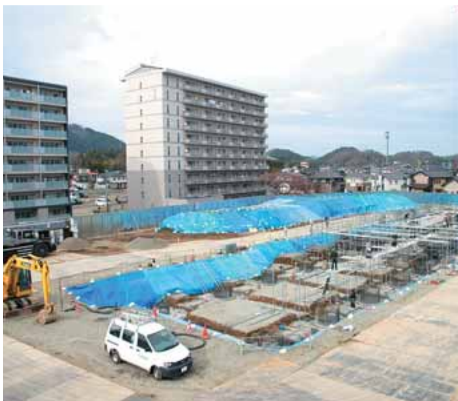
建設が進む北船岡町営住宅3号棟
