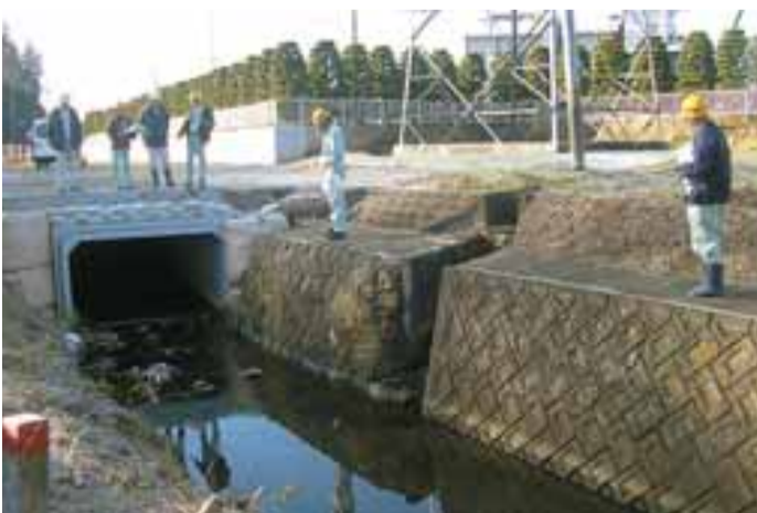
鷺沼1号雨水幹線工事現場
