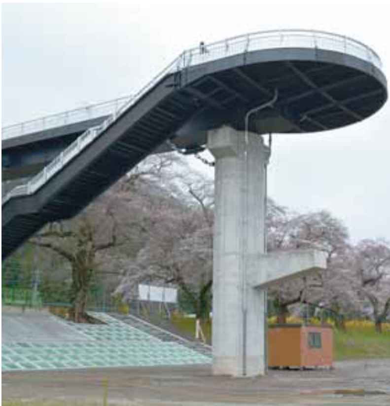
スロープが設置される「しばた千桜橋」
