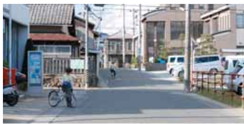
今年度の雨水対策工事（槻木生涯学習センター付近）
