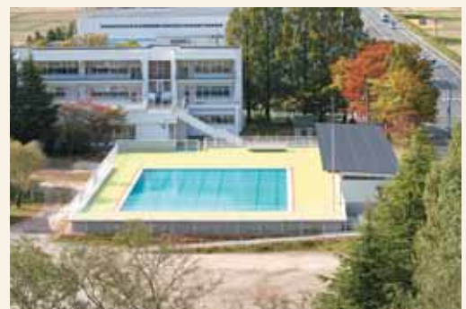
新しくなった榎木小学校プール
