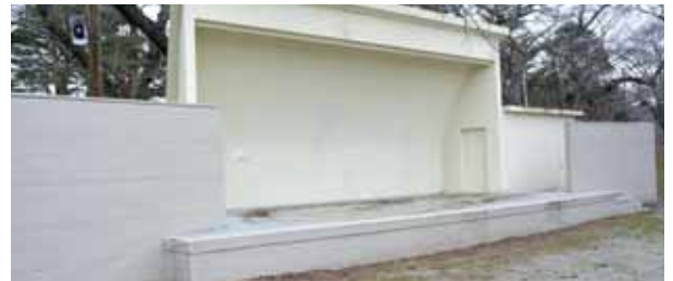
修繕予定の船岡城址公園三の丸ステージ
