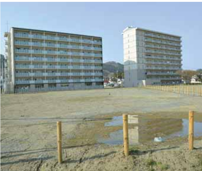
北船岡町営住宅3号棟建設予定地
