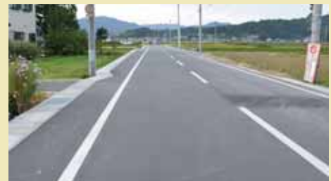
四日市場 1号線道路改修
