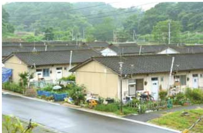
昭和43年～47年に建設された並松町営住宅
