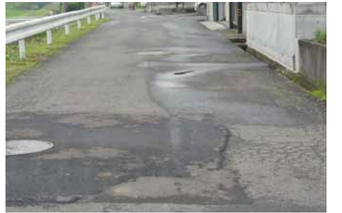
道路の補修は計画的に
