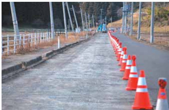
道路の復旧を早急に（復旧工事が進む町道船迫14号線）
