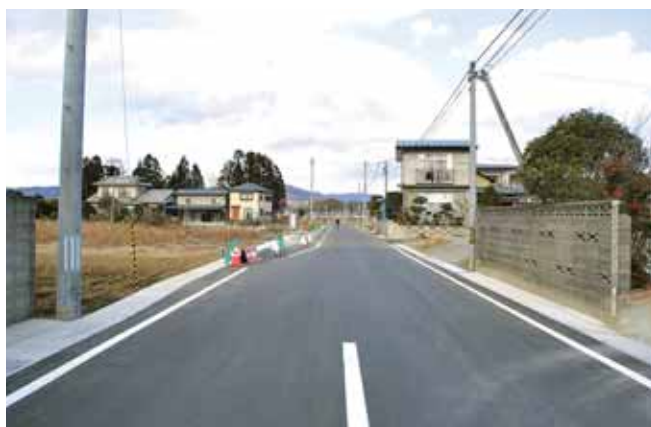
きれいに整備された町道四日市場1号線
