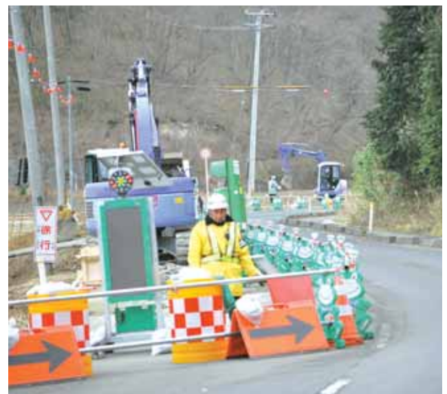
いよいよ本格的に工事開始(町道船迫2号線)
