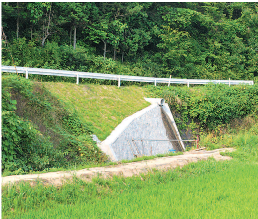
復旧した槻木用水（本船迫付近）
