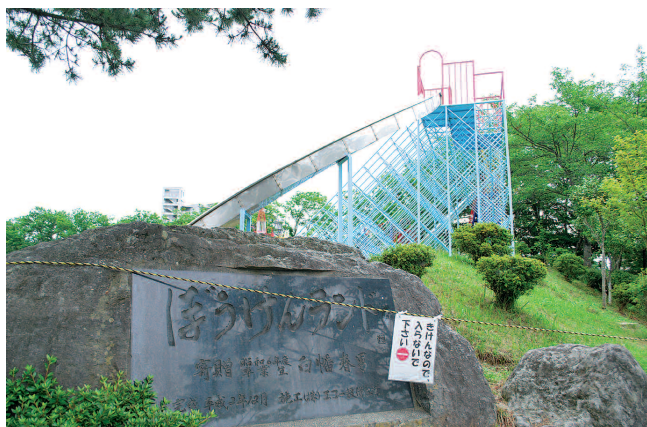
使用禁止となっている遊具
