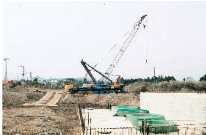
四日市場排水機場
