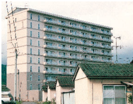
完成した北船岡町営住宅
