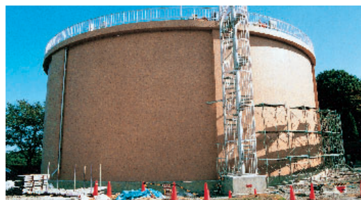
完成間近の山田沢 PC タンク
