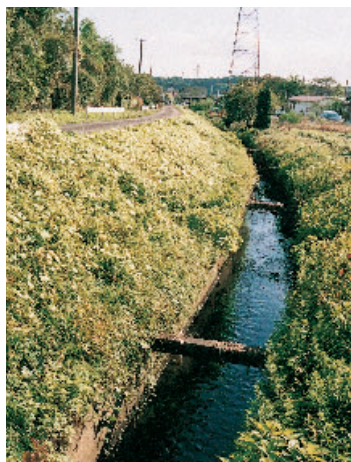
改修が望まれる鷺沼排水路
