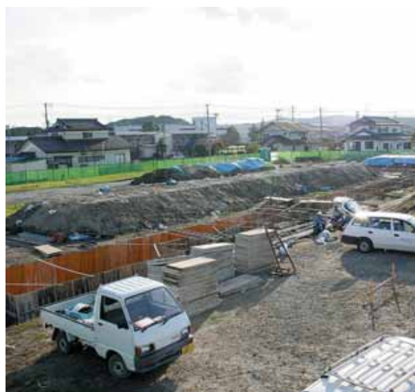
工事中の船岡保育所(新築)
