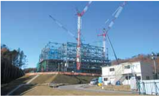
着々と進む建設工事
