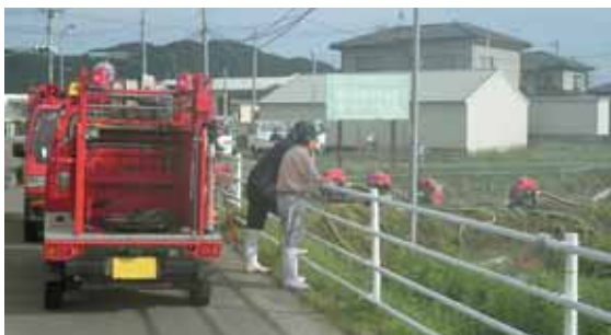
小型ポンプで排水にあたる(下名生地区)
