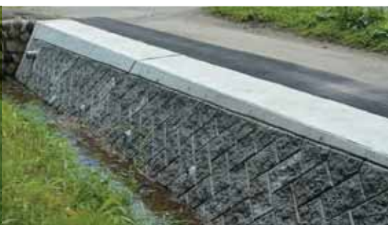
河川災害復旧工事
