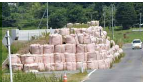
町道富沢16号線載荷盛土
