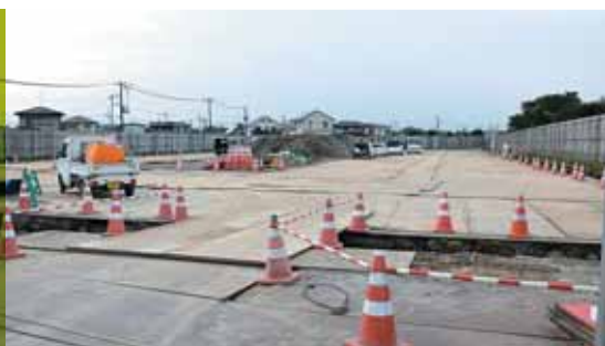
鷺沼排水区5号調整池
