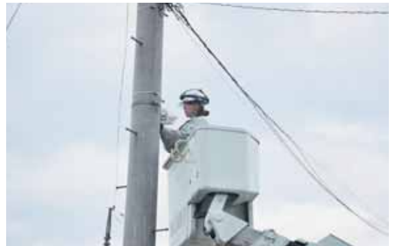
高所作業車で防犯灯の交換作業を行う清野さん
