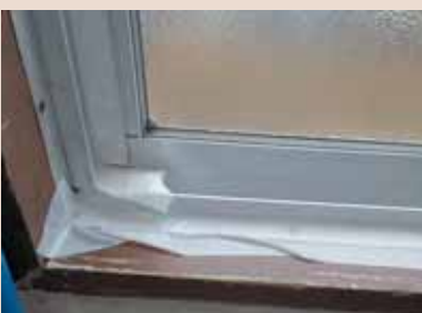
調理室 窓枠の応急処置
