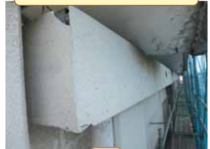
雨どいの修繕
