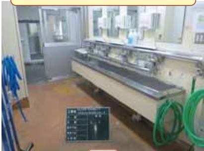
手指消毒室の流し台の修繕
