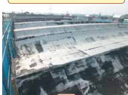
屋上屋根防水修繕
