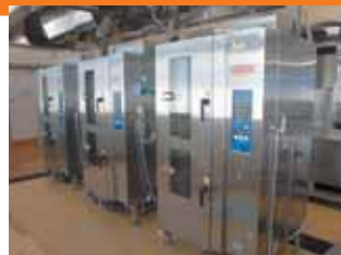
焼き物、蒸し物調理のためのスチームコンベクションオープン3基設置
