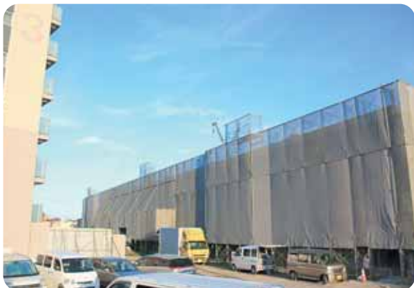
北船岡町営住宅4号棟
