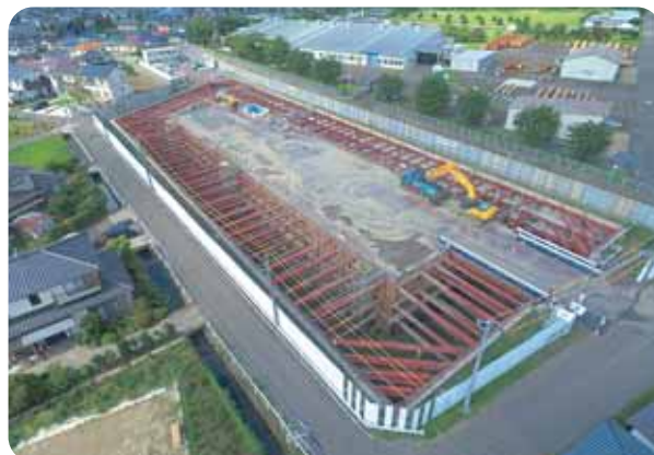
鷺沼排水区5号調整池
