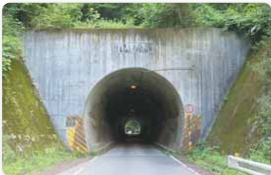
白山トンネル
