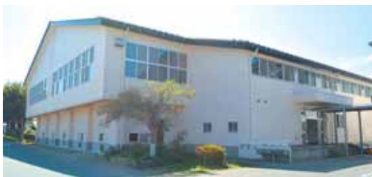
槻木中学校体育館
