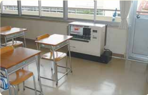
FF式暖房機を新設(船岡中学校)
