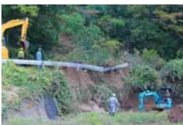
町道本船迫12号線で発生した崖崩れの復旧作業
