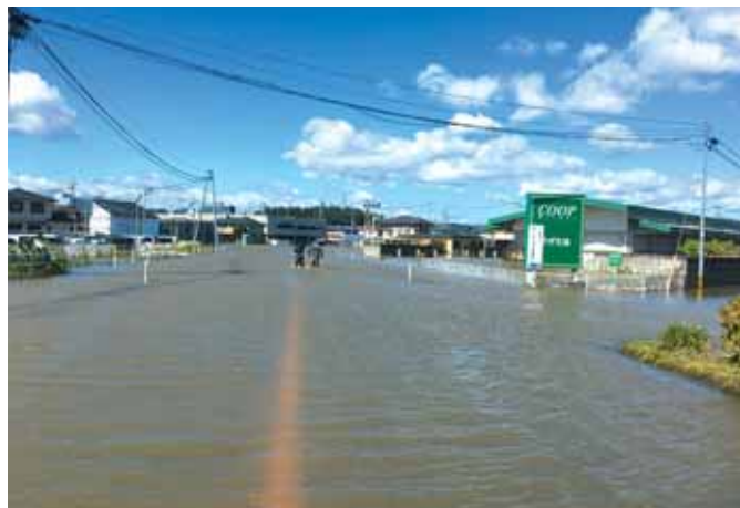
国道 349 号線みやぎ生協倉庫付近
