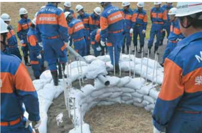
2年に1度実施される水防訓練
