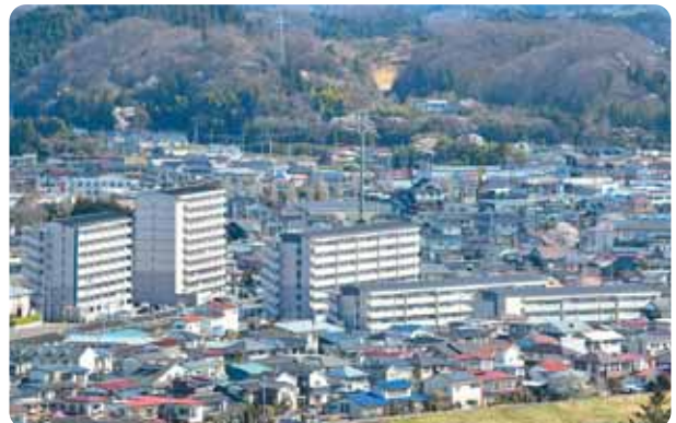
北船岡町営住宅1号棟～5号棟
