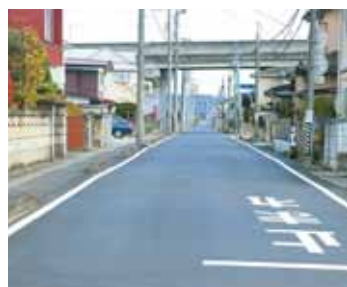
道路舗装の修繕(船岡土手内5号線など)に活用
