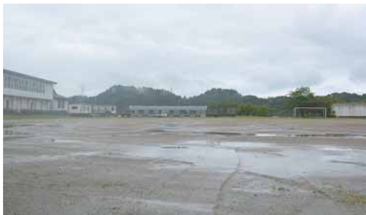
10月から工事が始まる船迫中学校校庭
