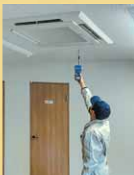
設置した空調機の風量測定を行う丸子さん
