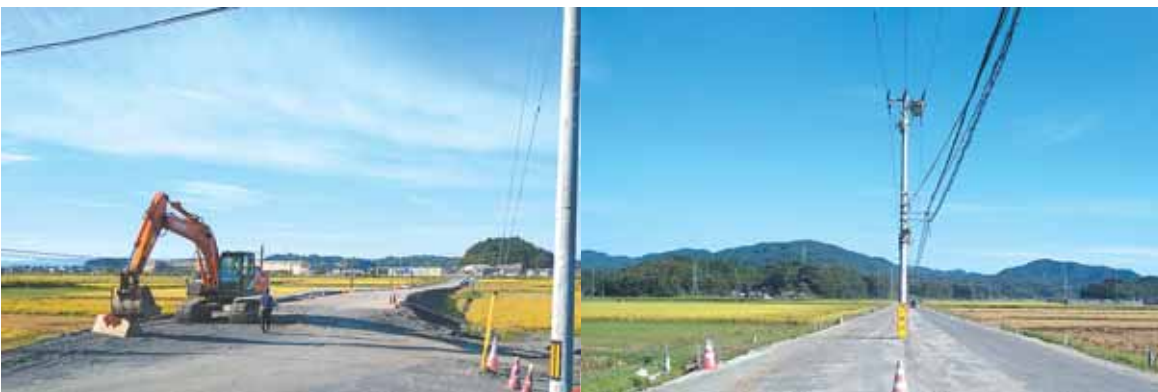
工事が進む町道富沢16号線 写真左：五間堀川から県道方面 写真右：中居交差点から富沢方面
