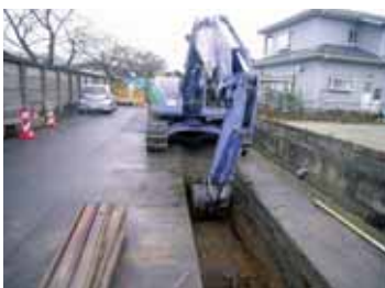
下水道工事(西住地区)
